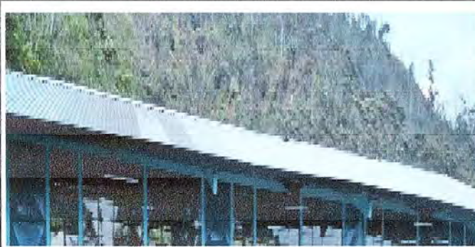
Foto 5: ASI QUEDO EL CAMBIO DE LOS CABALLETOS DEL ESTABLECIMIENTO
